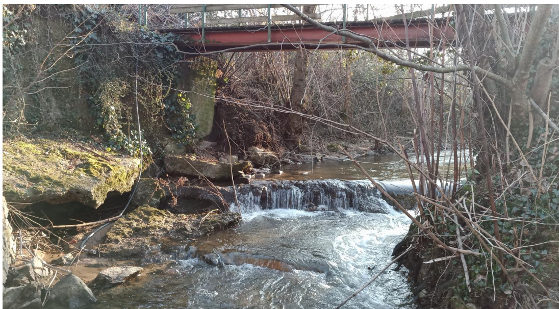
Figure 4 : photo de la chute induite par le seuil de la conduite EU
